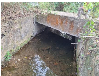
Vue sur la face amont de l'ouvrage
