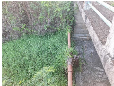
Aval du pont, ravine à sec en très basses eaux, végétation dense dans le lit
