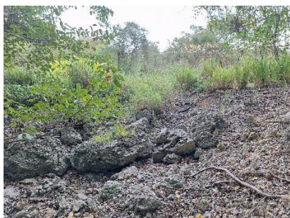
Vue amont du remblai
