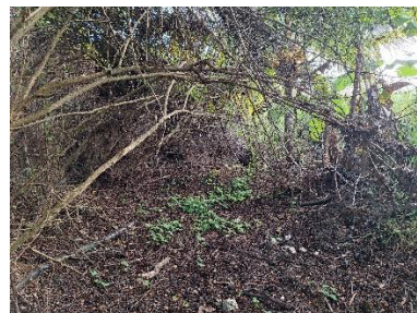
Talus en travers du lit de la ravine Cassis
