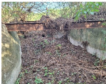
Murs de soutènement, rails métalliques
