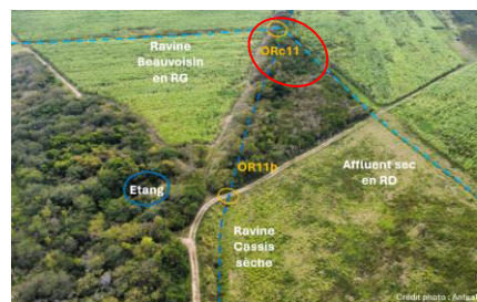
Vue satellite de la situation
