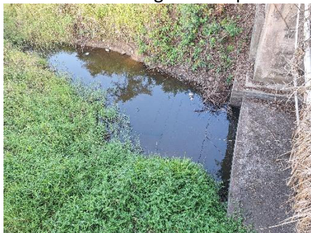
Amont du pont, dalle émergée de 30 cm
