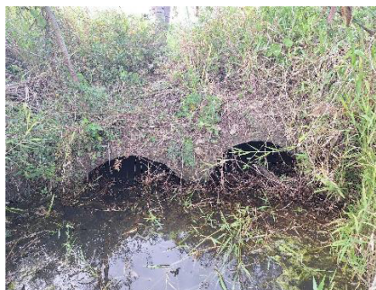
Vue sur l'aval des deux buses
