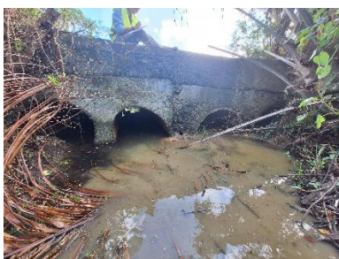
Vue sur l'amont de l'ouvrage
