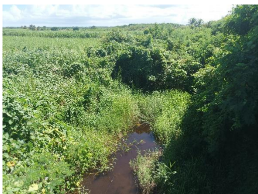
Aval du pont en moyennes-eaux
