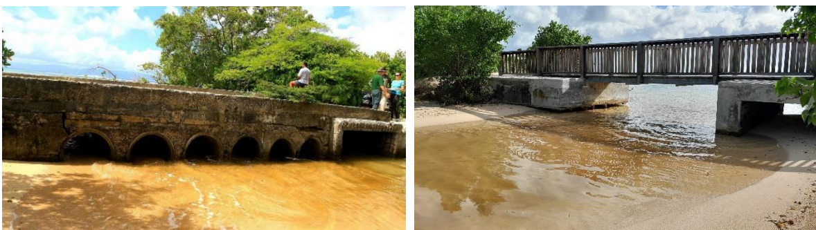
Figure 14 : Rénovation de l'exutoire de la Pointe des Mangles (source : ONF et Antea)
