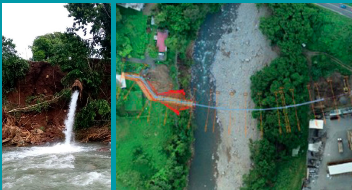
Figure 7 : Casse du feeder de Belle-Eau-Cadeau au niveau de la rivière Pérou à Capesterre-Belle-Eau (source : SMGEAG)
