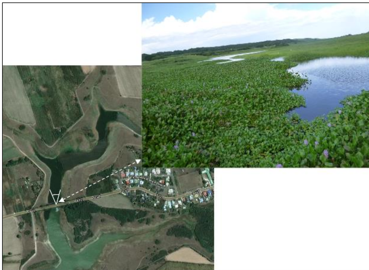
Figure 4 : Vue de la partie située en amont du pont, observée depuis l'embarcation placée sous le pont : la navigation n'y est pas possible.
