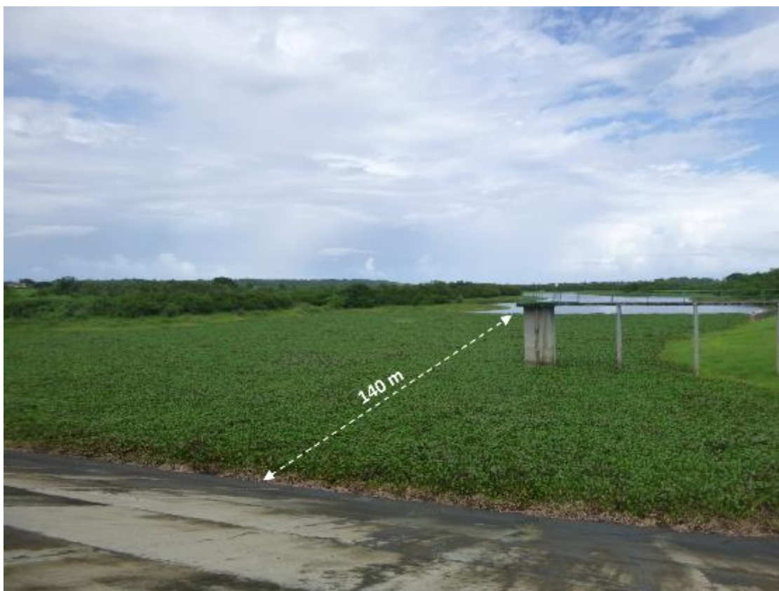
Figure 3 : Vue de la partie amont du barrage observée depuis le barrage
