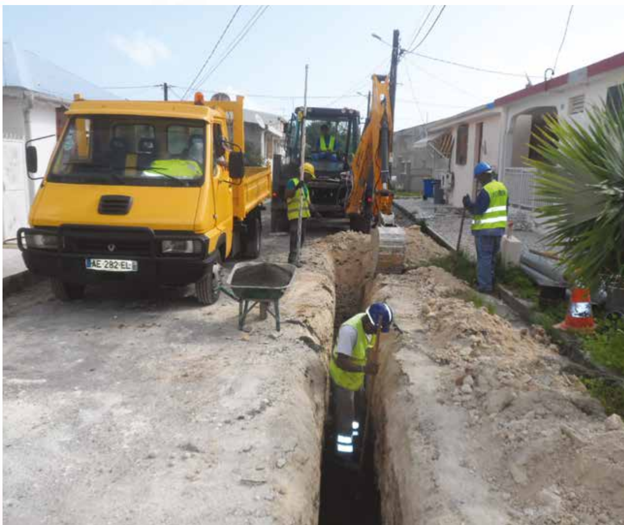
Figure 26 : Pose d'un réseau de collecte d'eaux usées (source : Office de l'Eau)
