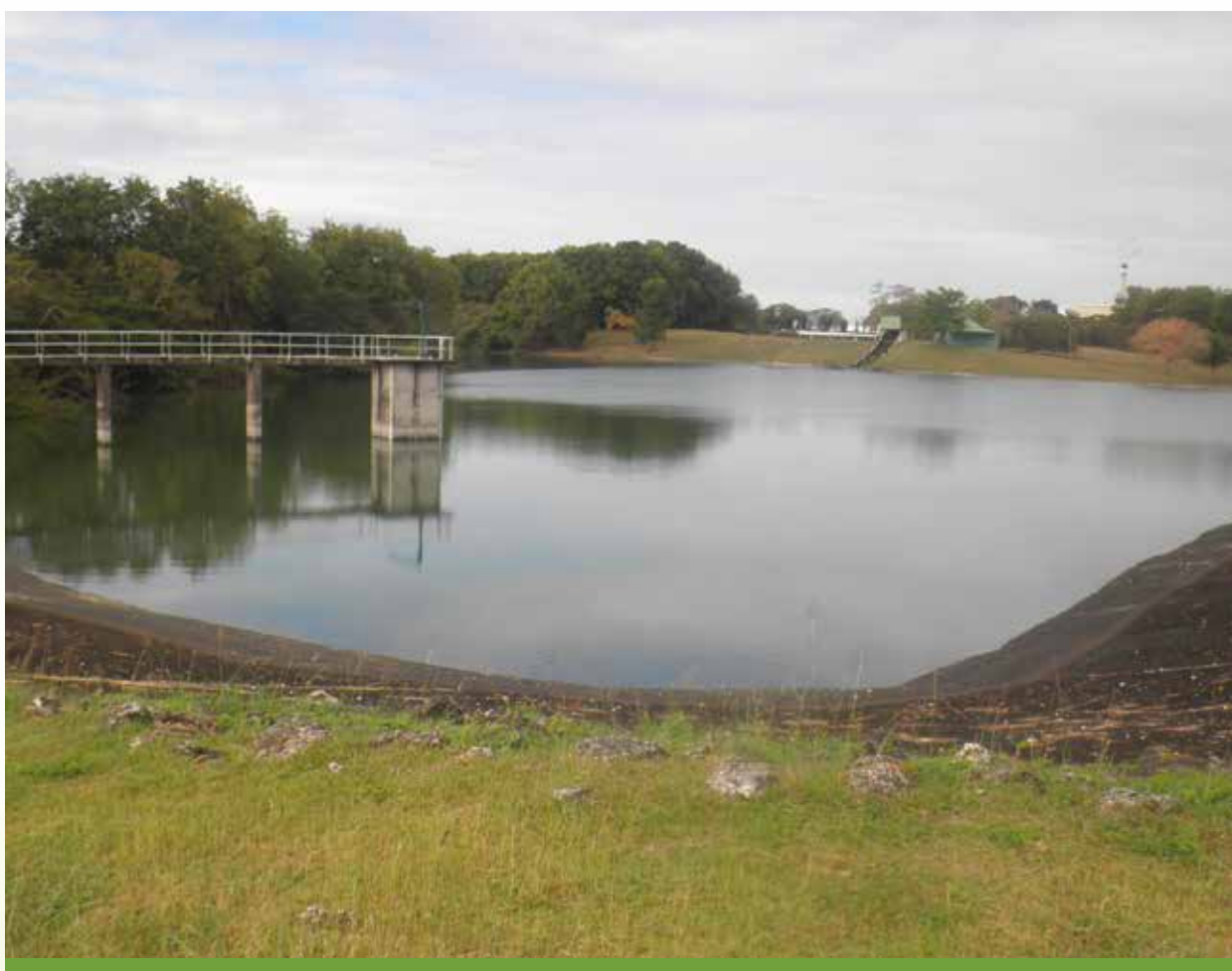
Figure 11 : Barrage de Letaye (source : Office de l'Eau)
